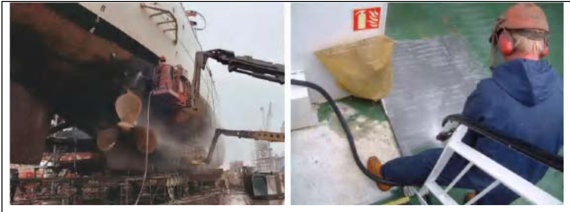
Slika 10. Priprema površine vodenim mlazom [6]
